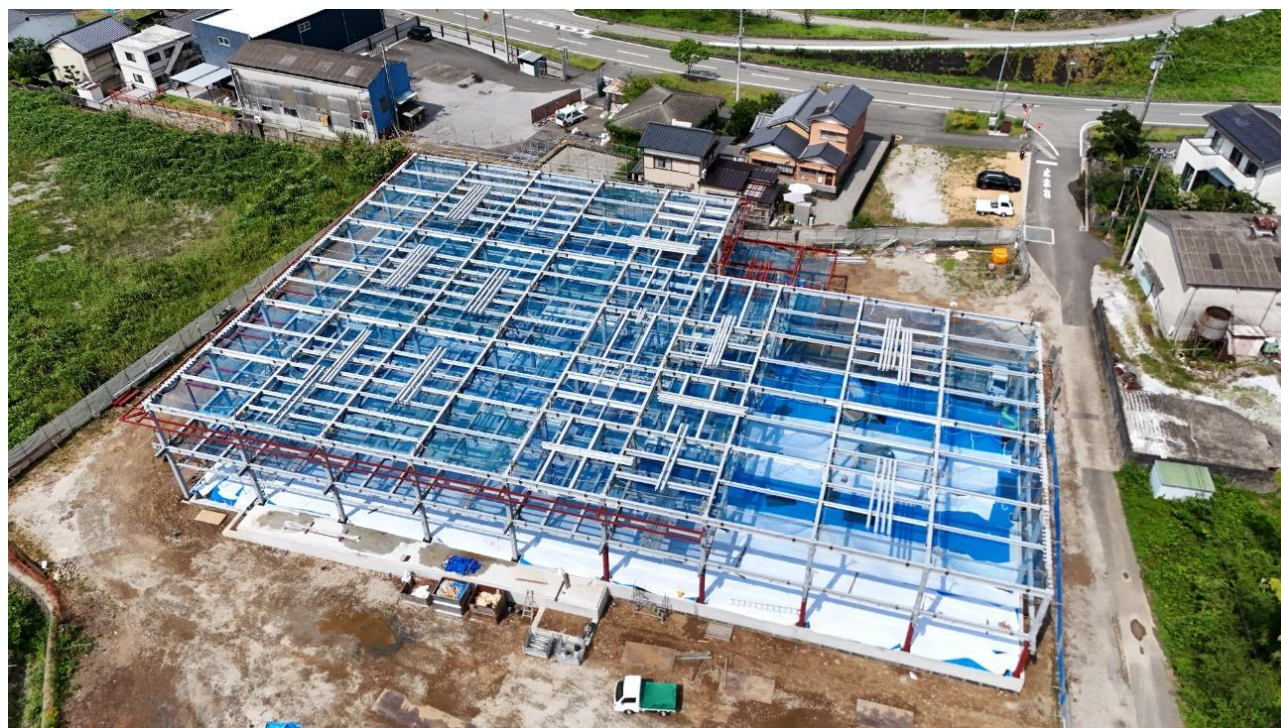
民間商業施設の現場（2025）
